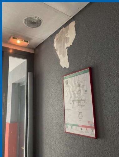
Avant les travaux
