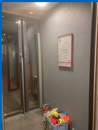
Après les travaux
